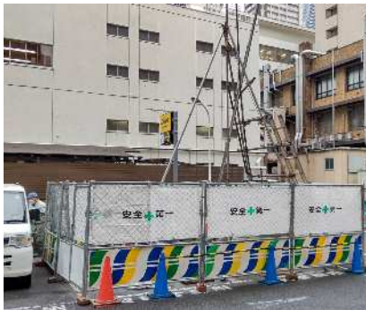
ボーリング機械仮設参考図
